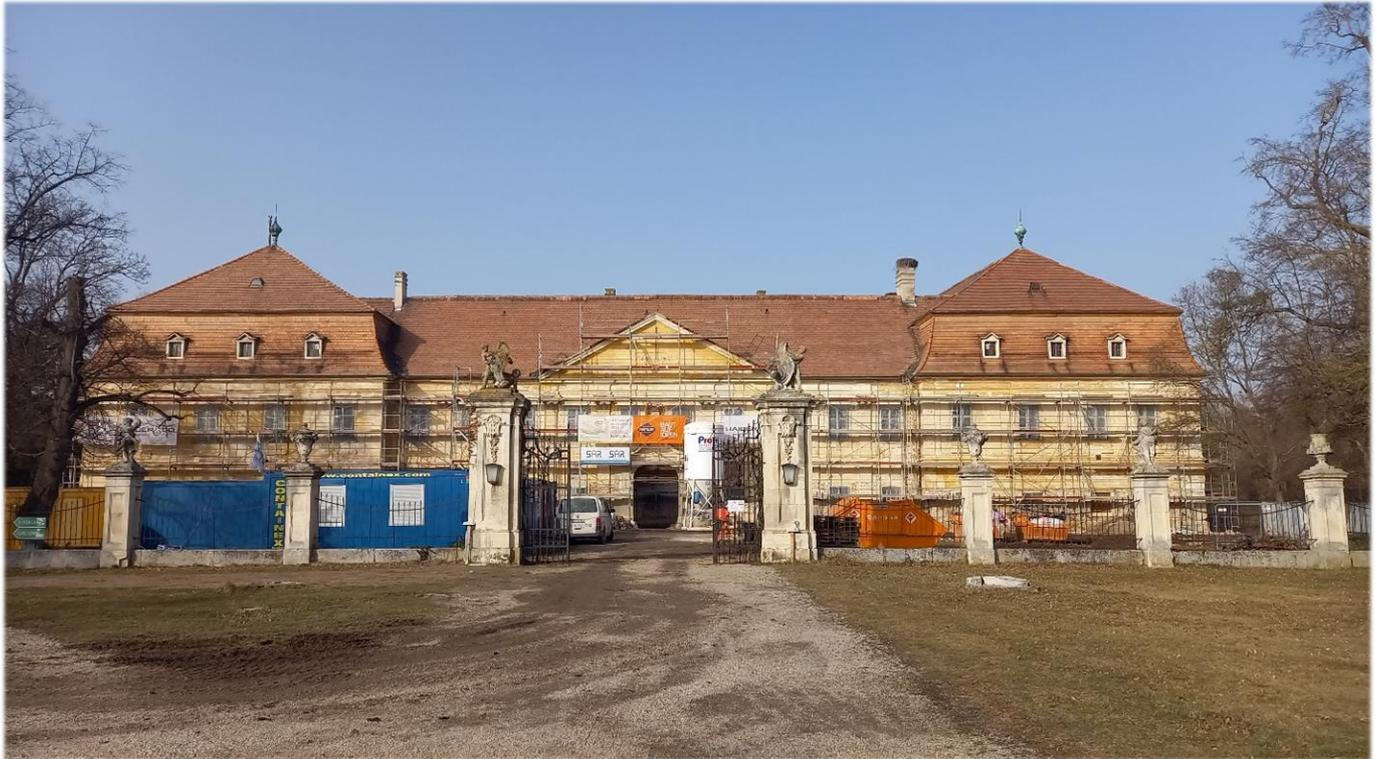
Die eingerüstete Südfassade nach dem Entfernen des Zementputzes
