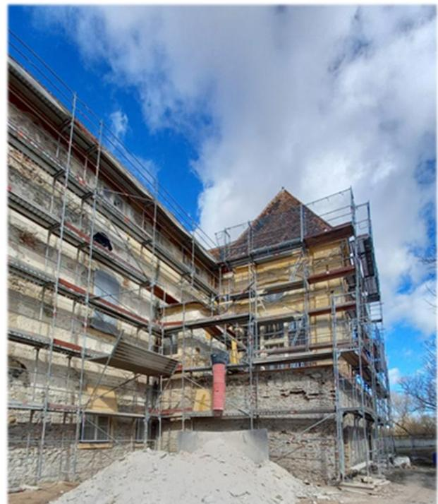
Der Pavillon und die Ostfassade nach dem Entfernen des Zementputzes
